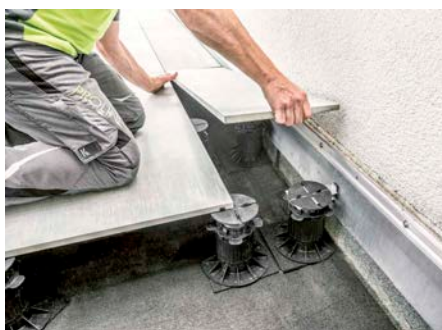
Sichere Verlegung von Outdoor-Keramik und Naturstein auf Dachterrassen mit dem System „Prostilt“. Foto: Proline
