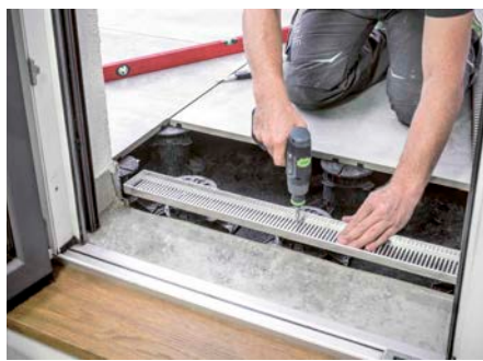
Verlegung des Rinnensets nach DIN18040-2 Foto: Proline
