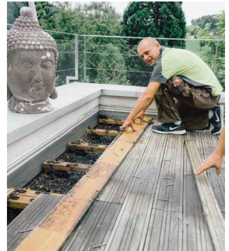
Die unansehnliche Holzterrasse wurde demontiert. Foto: Proline
