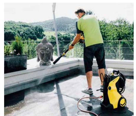
Reinigung der Bitumenbahn – denn sie bleibt bei der Sanierung selbstverständlich erhalten. Foto: Proline
